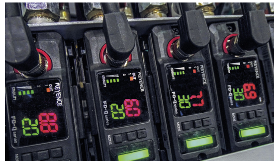
Medición del caudal por ultrasonidos sin mantenimiento
